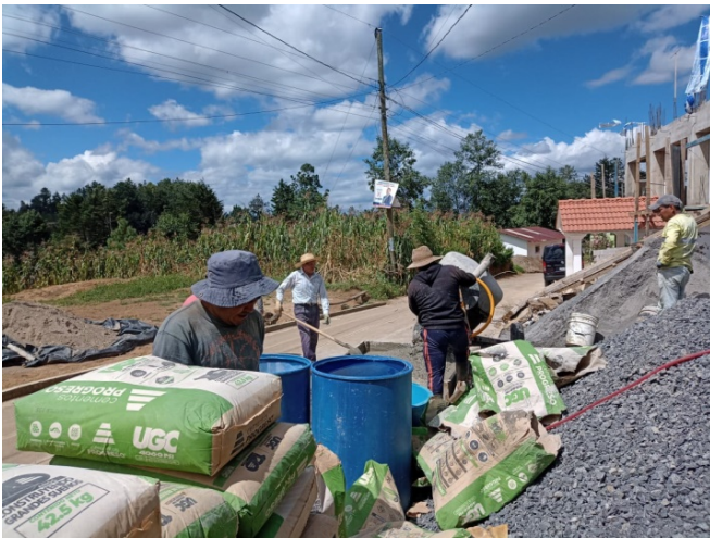
Bau des 3. Stockwerks: Beginn der Bauarbeiten im April
