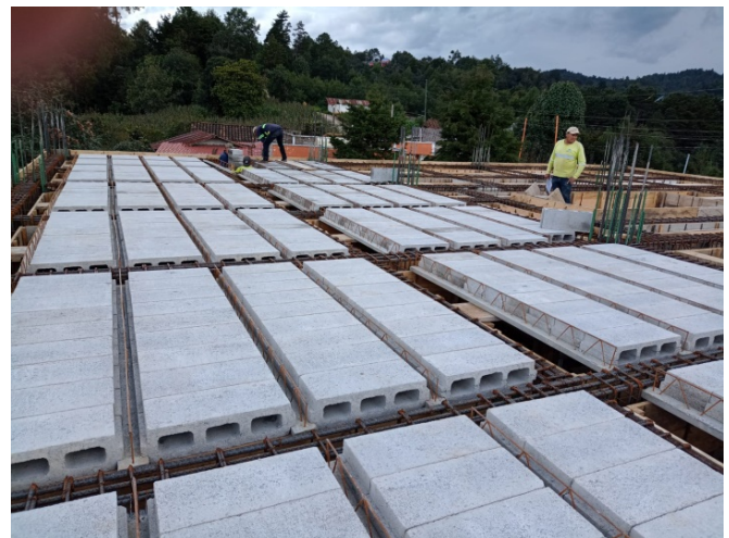
Neue Decke (Flachdach) aus Betonfertigteilen
